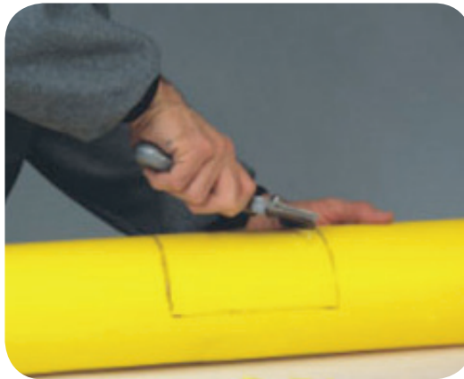
Oksitli tabakanın traşlanması/ Scraping the oxide layer
