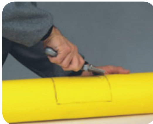
Oksitli tabakanın traşlanması/ Scraping the oxide layer
