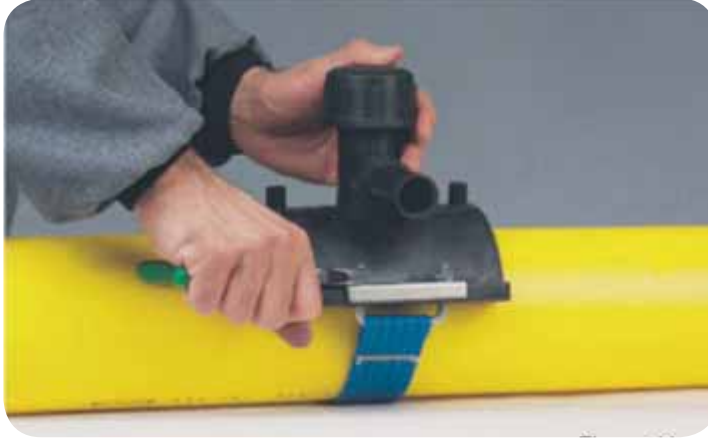
Te-branşmanın kaynak öncesi boru üstünde sıkılması/ Tightening of Tee-branch on the pipe
