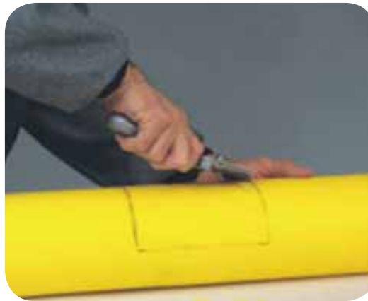
Oksitli tabakanın traşlanması/ Scraping the oxide layer
